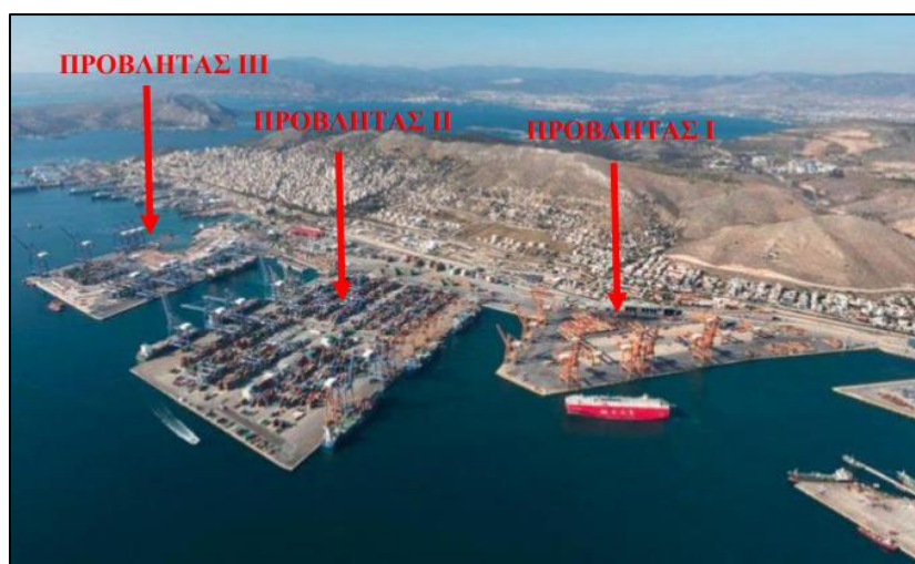
Εικόνα 23: Container Terminal Πέραμα (Πηγή: PIREAS news.gr, Λαγουδάκη Δ., 2018)
